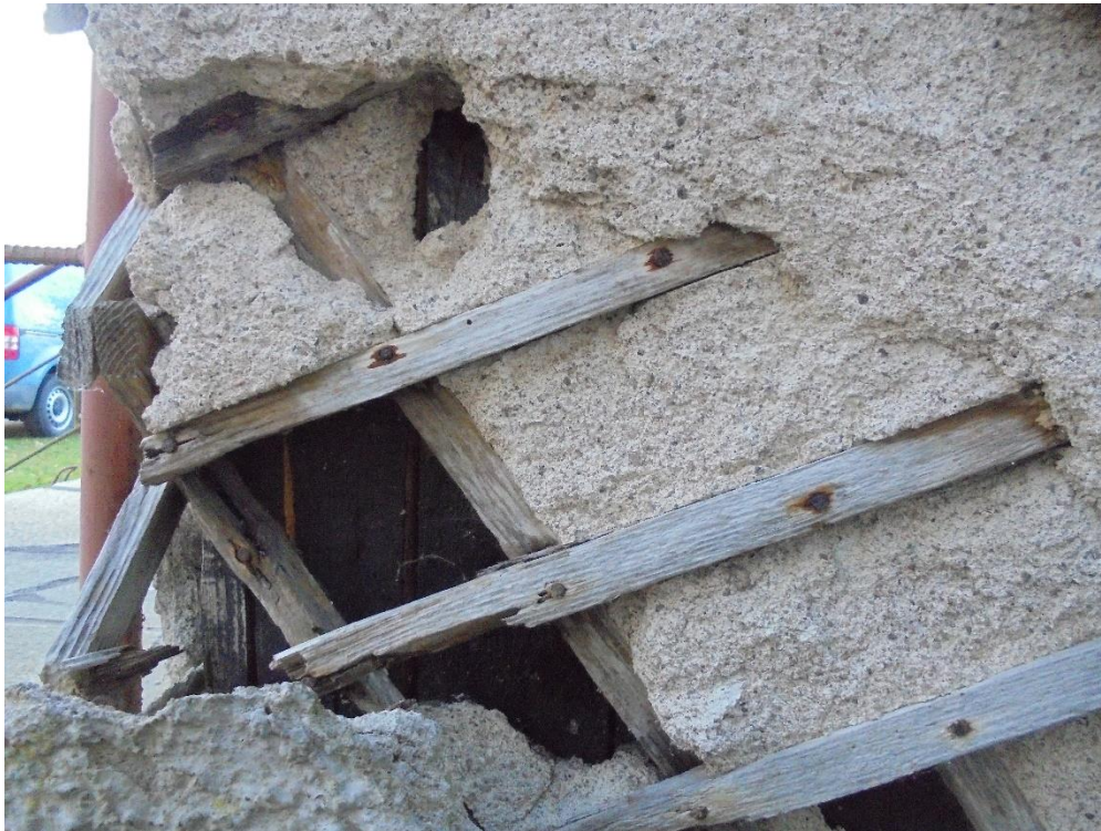
Kuva 7 Rappauksen alla olevan umpilaudoituksen ulkopinta on käsitelty kreosoottipitoisella pikisivelyllä.
