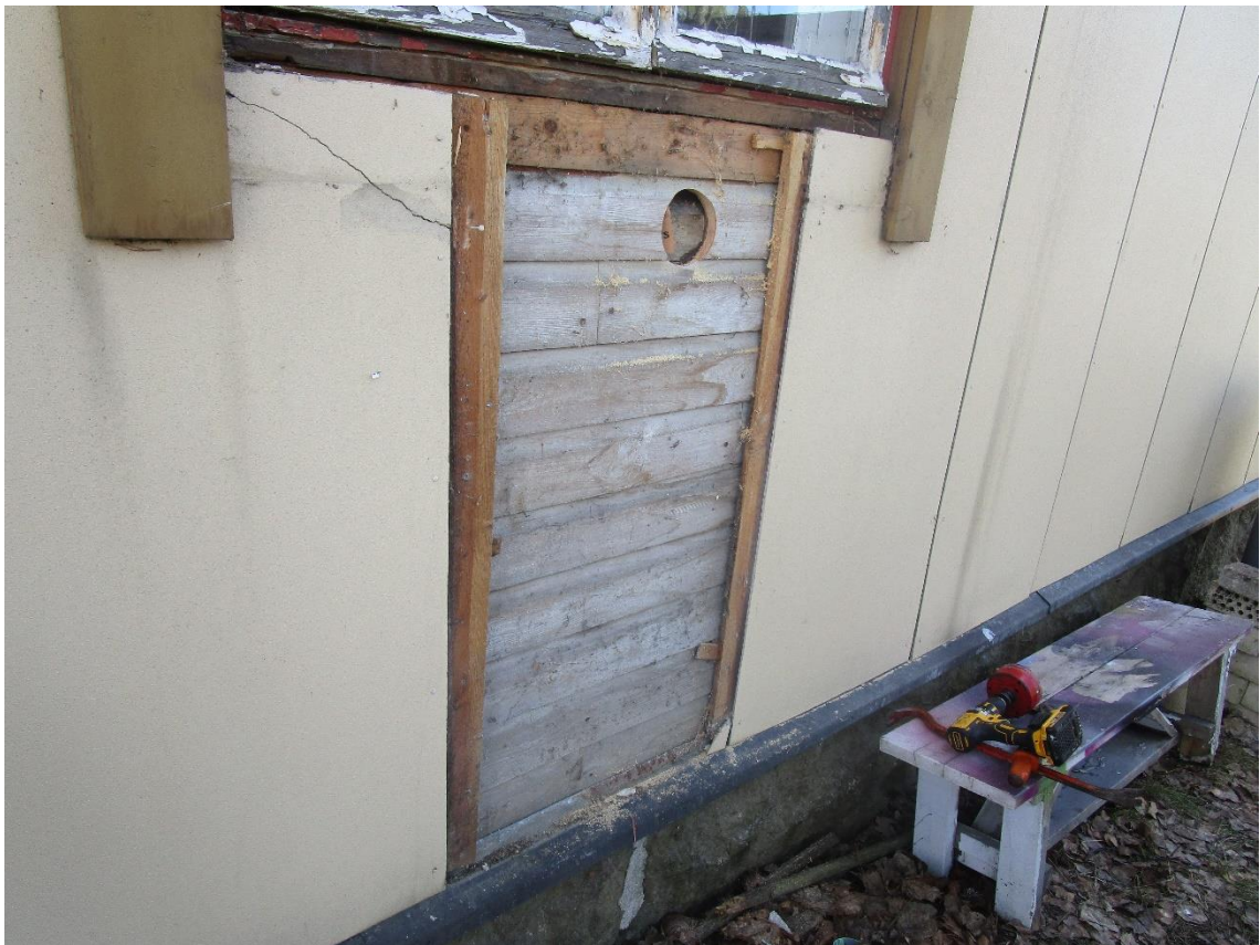
Kuva 4 Useimmiten alkuperäisen ulkovooren päälle on lisätty koolaus, jonka päälle Minerit-levyt on kiinnitetty. Tällöin rakenteeseen on muodostunut tuuletusrako.
