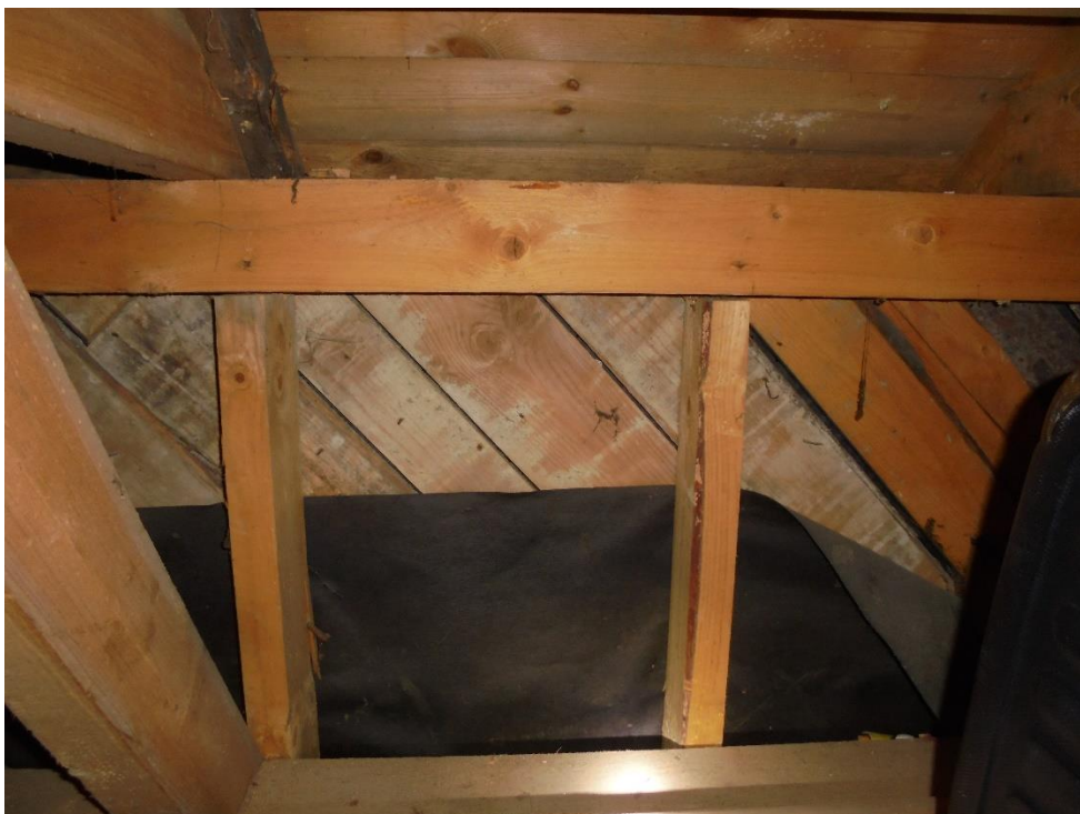
Kuva 9 Tämän rintamamiestalon seinärakenteessa on kreosottipitoinen tervapahvi kolmessa eri kohdassa eli ulkovuoren ja vinolaudoituksen välissä, vinolaudoituksen ja lämmöneristeen välissä sekä lämmöneristeen ja vaakasuuntaisen umpilaudoituksen välissä.
