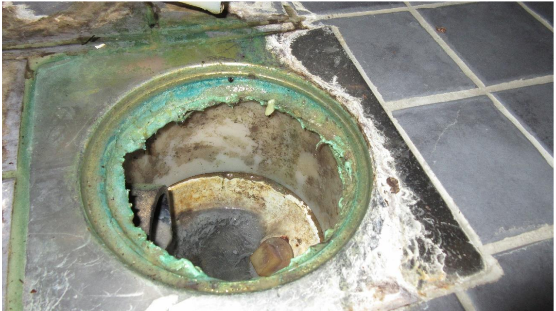
Kuva 67 Lattiakaivosta näkyy vedeneriste sekä korokerengas.
