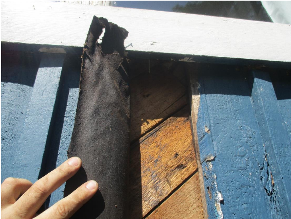
Kuva 8 Ulkovuoren alla on kreosottipitoinen tervapahvi tuulensuojakerroksena.
