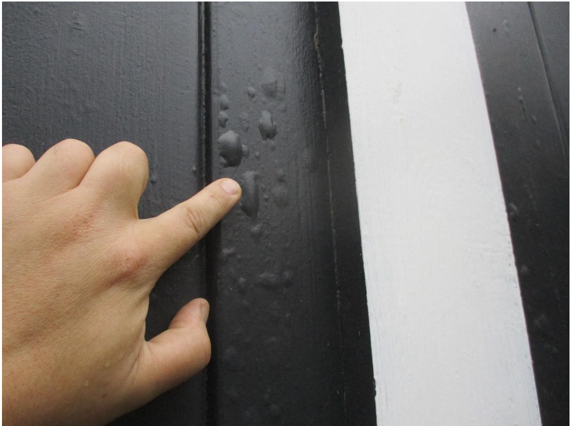
Kuva 57 Maalipinnan kupliminen ei ole merkki kosteusvauriosta.
