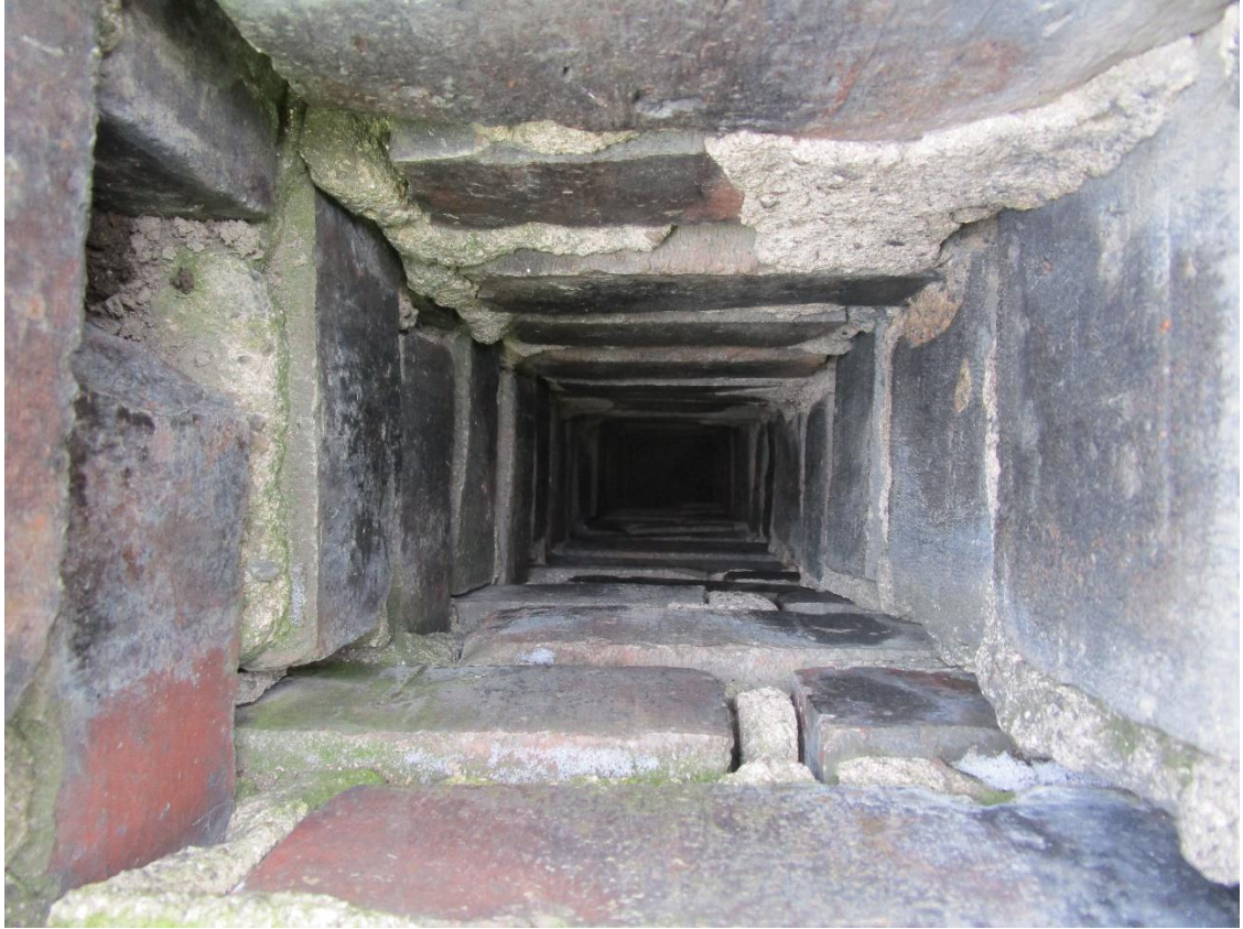
Kuva 65 Savupiippujen hormit tarkastetaan vesikatolta käsin kameralla kuvaamalla.
