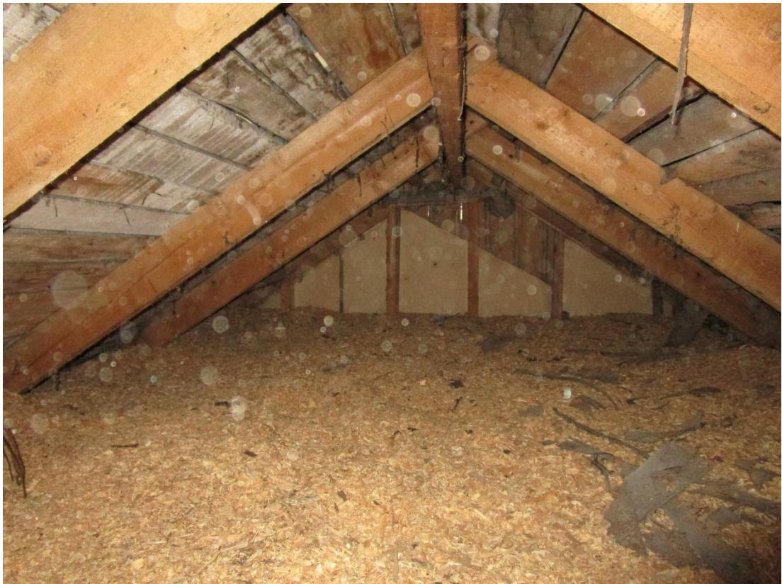
Kuva 60 Vaikka tuuletusta ei ole, ovat rakenteet hyvässä kunnossa.
